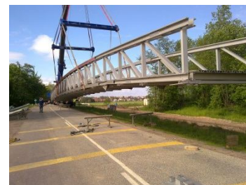
Vue de la passerelle
