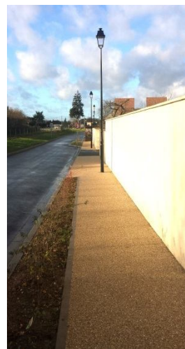
Cheminement piéton en béton désactivé
